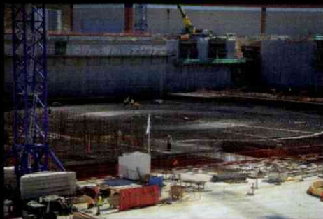
Les fondations qui supporteront les 360 000 tonnes du complexe tokamak comportent 493 plots parasismiques, bientôt recouverts par une deuxième dalle de béton.
