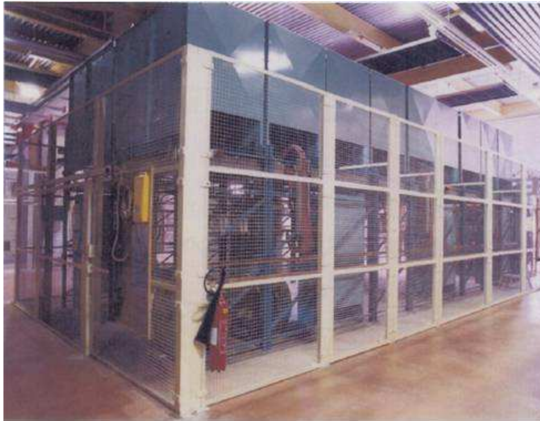
Tore Supra TF system FSD resistor
